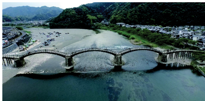
▲図1 錦帯橋全景写真： ドローン撮影小林徹 (COMMAND+N)
